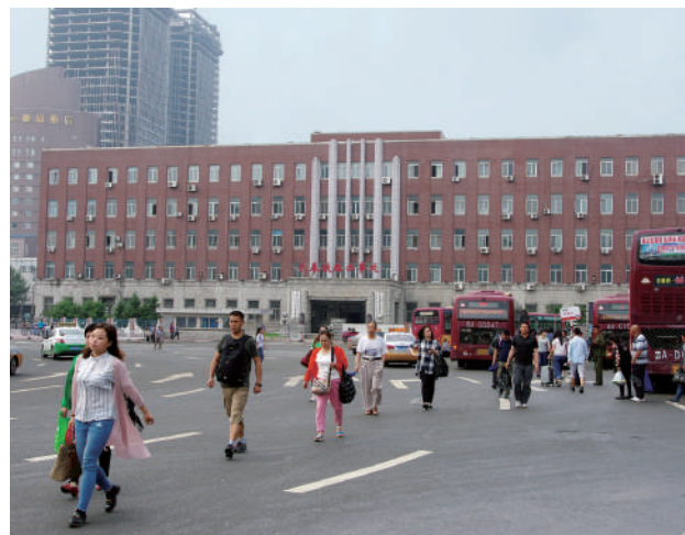
写真19：新京満鉄綜合事務所（現・長春铁路事務所）
