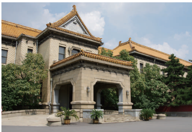
写真13：同徳殿正面玄関、建物は南面し長辺約90m、奥行約25m
