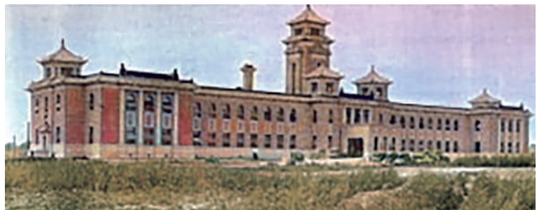
写真3上：第一庁舎（特別市公署、1945年以降建て替えられた） 写真4下：第二庁舎（首都警察庁、現・長春市公安局） （いずれも『満洲建築協會雑誌』昭和8年11月号掲載）
