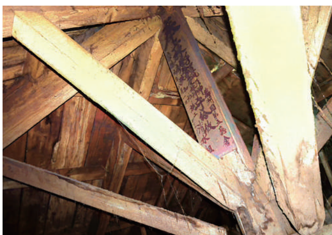
写真7：第五庁舎中央宝形屋根小屋組に取り付けられた棟札（北京房修一建築工程有限公司提供）
