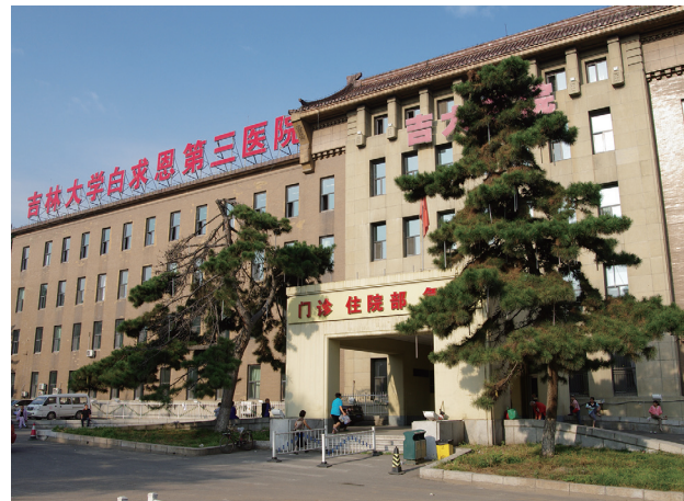
写真11：第十庁舎、經濟部（現・吉林大学白求恩第三医院）。外壁はテラコッタタイル
