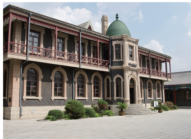
写真12：満洲国皇宮内の中心的な建物、勤民楼。□の字形の平面形状で内部は吹抜け
