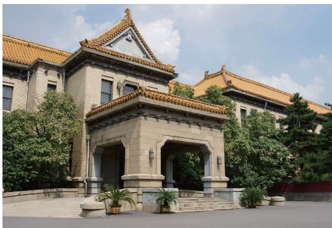
写真13：同徳殿正面玄関、建物は南面し長辺約90m、奥行約25m
