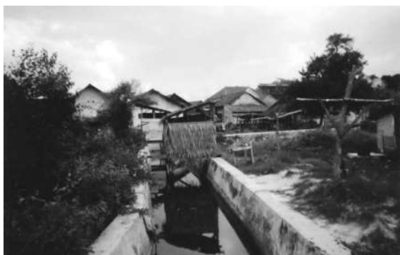
用水路とトイレ
