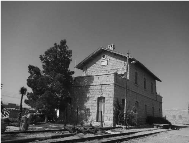
図3 ヒジャーズ鉄道 カトラナ (Qatranah) 駅
