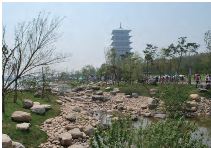
シンボルタワー
