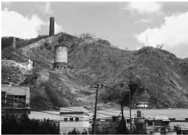
枯れた山稜を這い上るムカデ煙道（隧道）と山腹のダルマ煙突。最後の山頂の煙突は世界一になった。1981年（昭和56年）銅山閉鎖後、12年たって上3分の2が台風で倒壊した。
