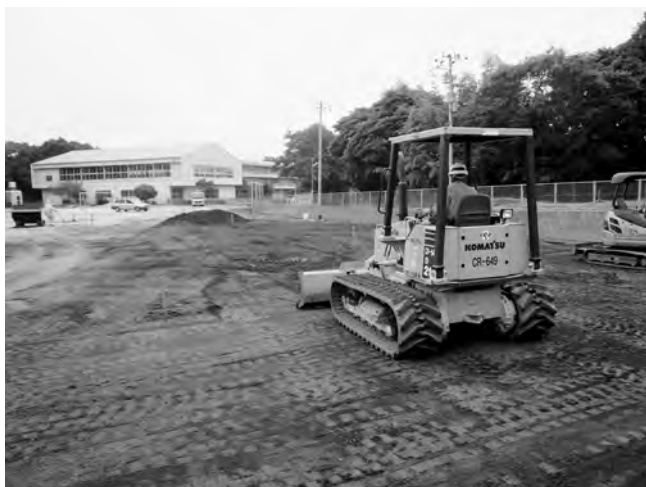
校庭表土の除染作業
