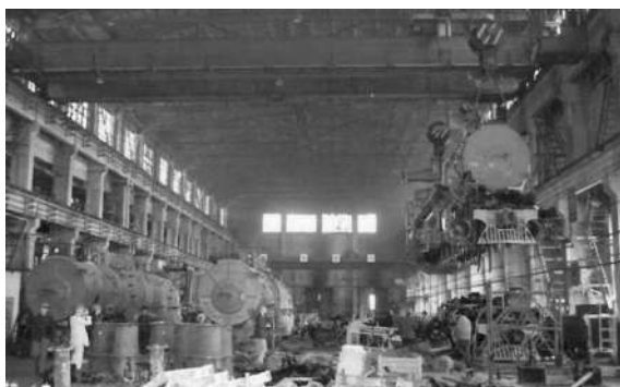
写真4 前進形蒸気機関車の車入れ作業
