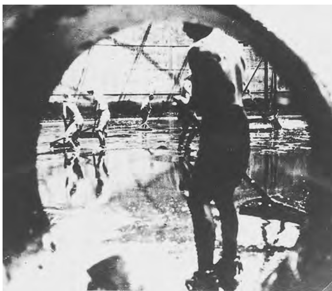
タンク底油の回収作業
